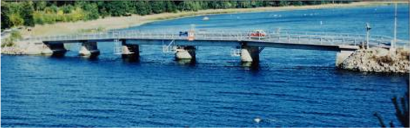
Fig. 1: Tottnäsbron med aluminiumdeck (Foto SAPA)
