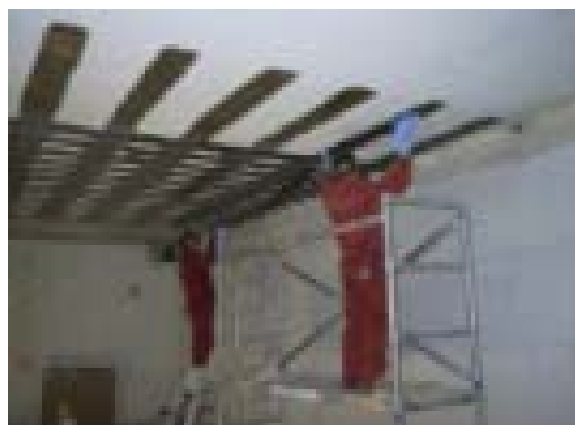
Bild 2. Pultruderad kolfiberremsa. (ovan) Applicerings av pultruderade kolfiberremсор. (nedan)
