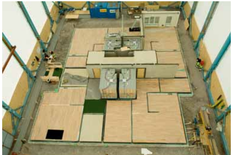
NCCs byggplats blir montageplats i en väderskyddad och utrustad produktionshall.
