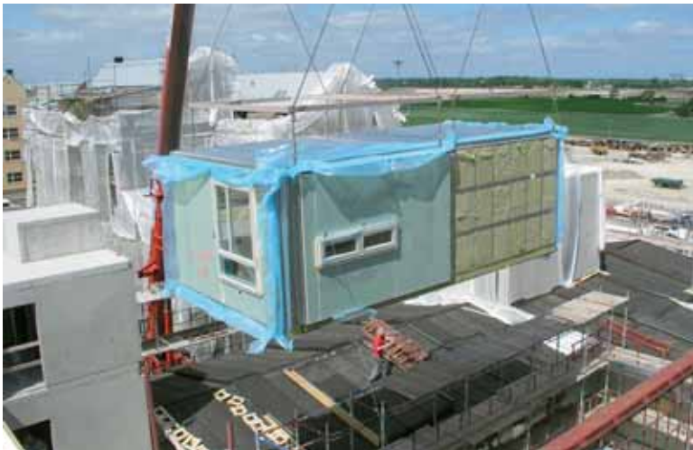
Volymelement från Open House lyfts på plats för slutmontage.
