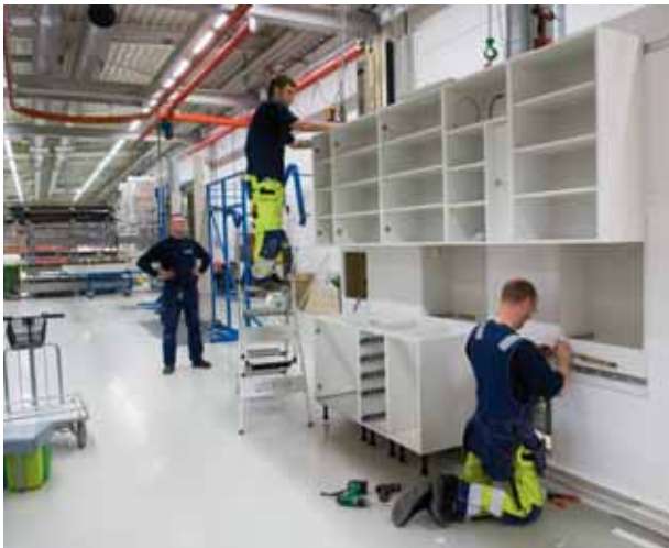
Köksinredning monteras på väggelement i NCCs fabrik.
