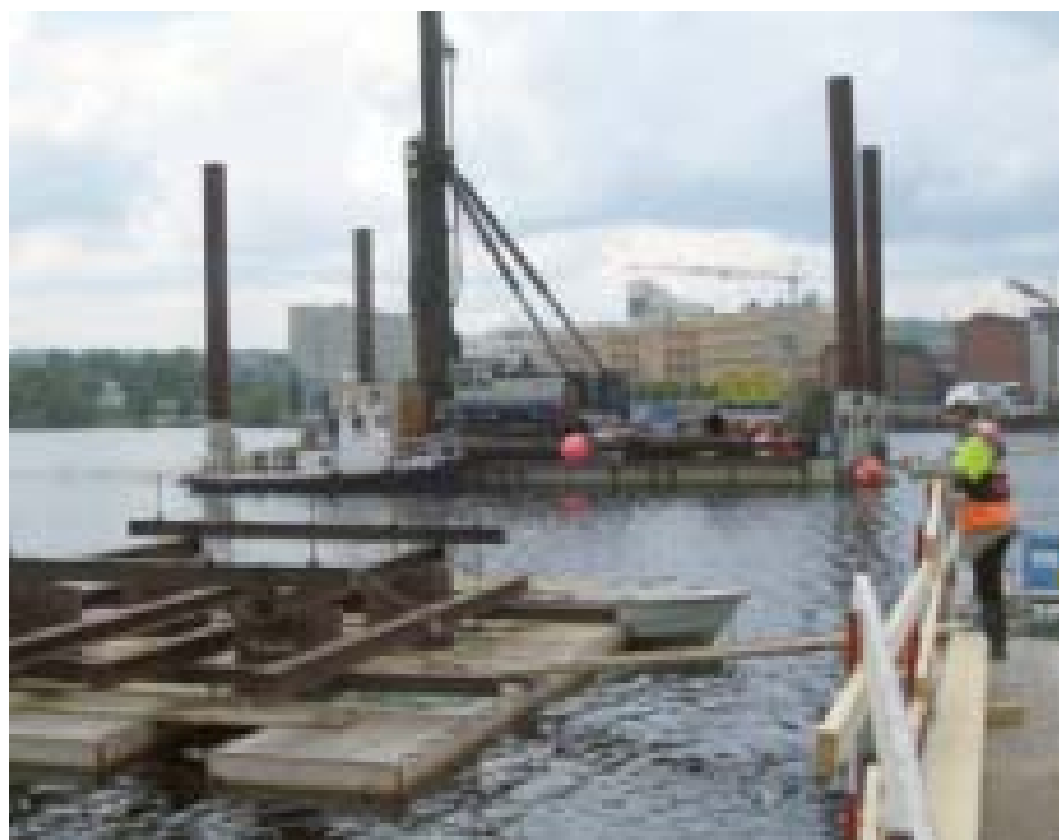
Figur 1. Påslagning för ett av mittstöden.
