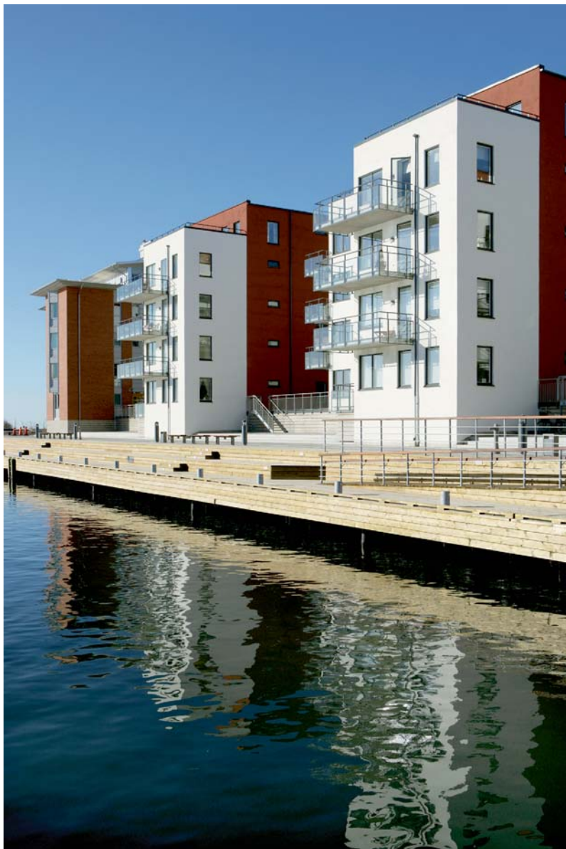
Hyresrätter byggda till Nyhamnshus i Landskrona hamn.
