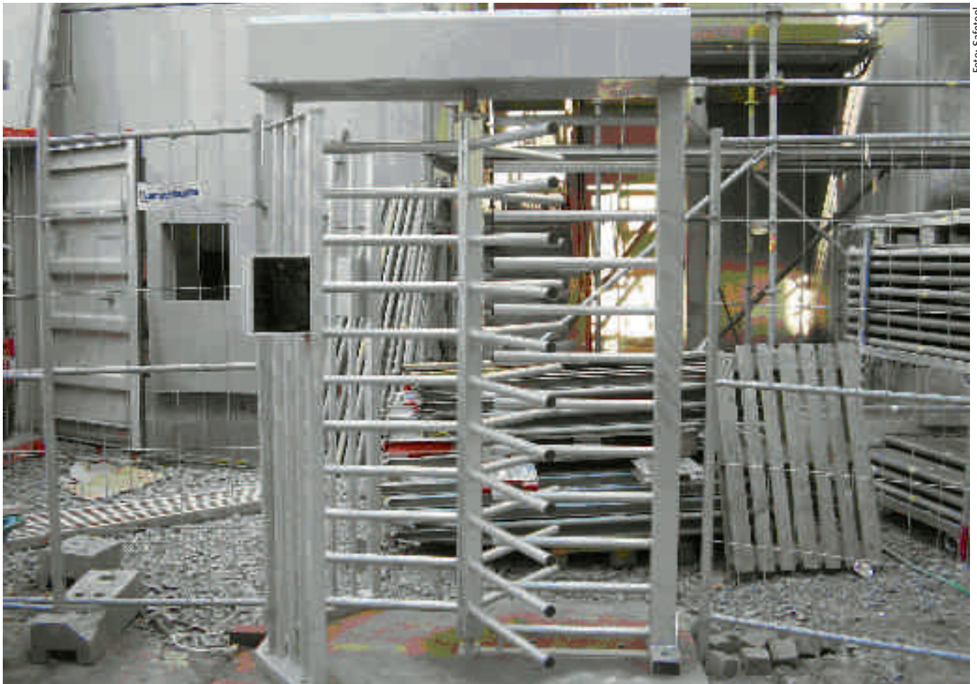
Figur 1. RFID-baserad rotationsgrind för inpassering på byggarbetsplats.
