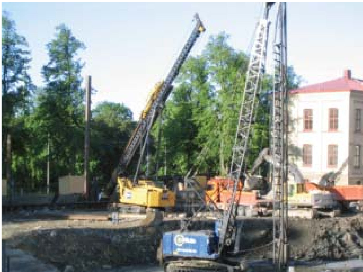
HEA 300 stål balk installeras med en 65 t BSP-CPR.
